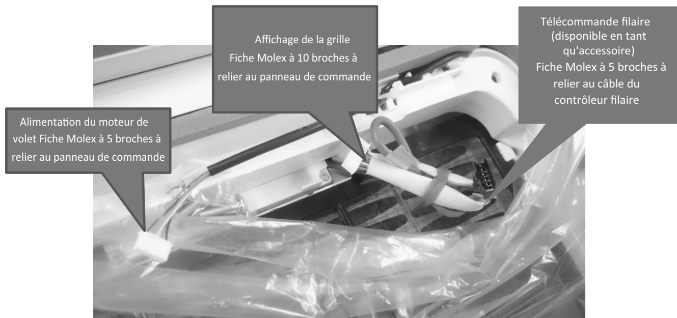
Fig. 55 - Branchements du panneau du module à cassette
